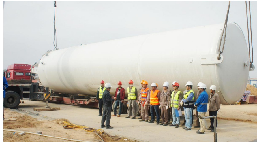
陕西榆林天正项目大件设备吊装前安全技术交底
