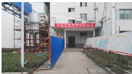
现场隔离通道
